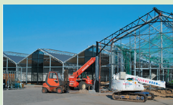
Bodenstaff in aanbouw
